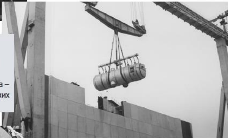
Рис.4 Завершающий этап послыйного монтажа технологического оборудования в боксах парогенераторов. Установка четвертого парогенератора с приваренным коллектором пара при открытом куполе и отсутствии перекрытия на отм. 36,9 м. Следующая операция – установка ОМФ перекрытия 36,9 м и создание локальной зоны «чистого» монтажа в боксах парогенераторов
